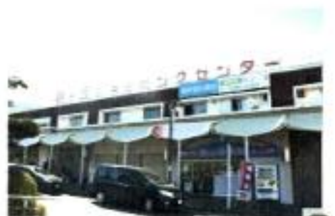
藤が丘ショッピングセンターは来年度以降に解体される＝横浜市青葉区
